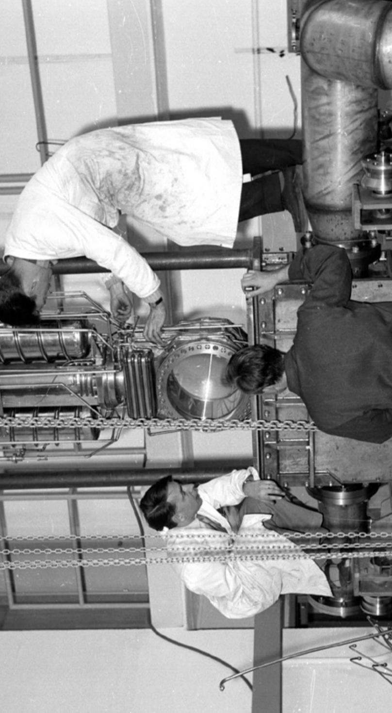
In den 50er und 60er Jahren waren Blasen- und Funkenkammern das vorherrschende Werkzeug der Hochenergiephysik. CERNs erste Blasenkammer von 30 cm Durchmesser, gefüllt mit flüssigem Wasserstoff, wird in den Vakuumbehälter eingesetzt. Links im Bild aus dem Jahre 1959 sieht man H. Flithuth.
