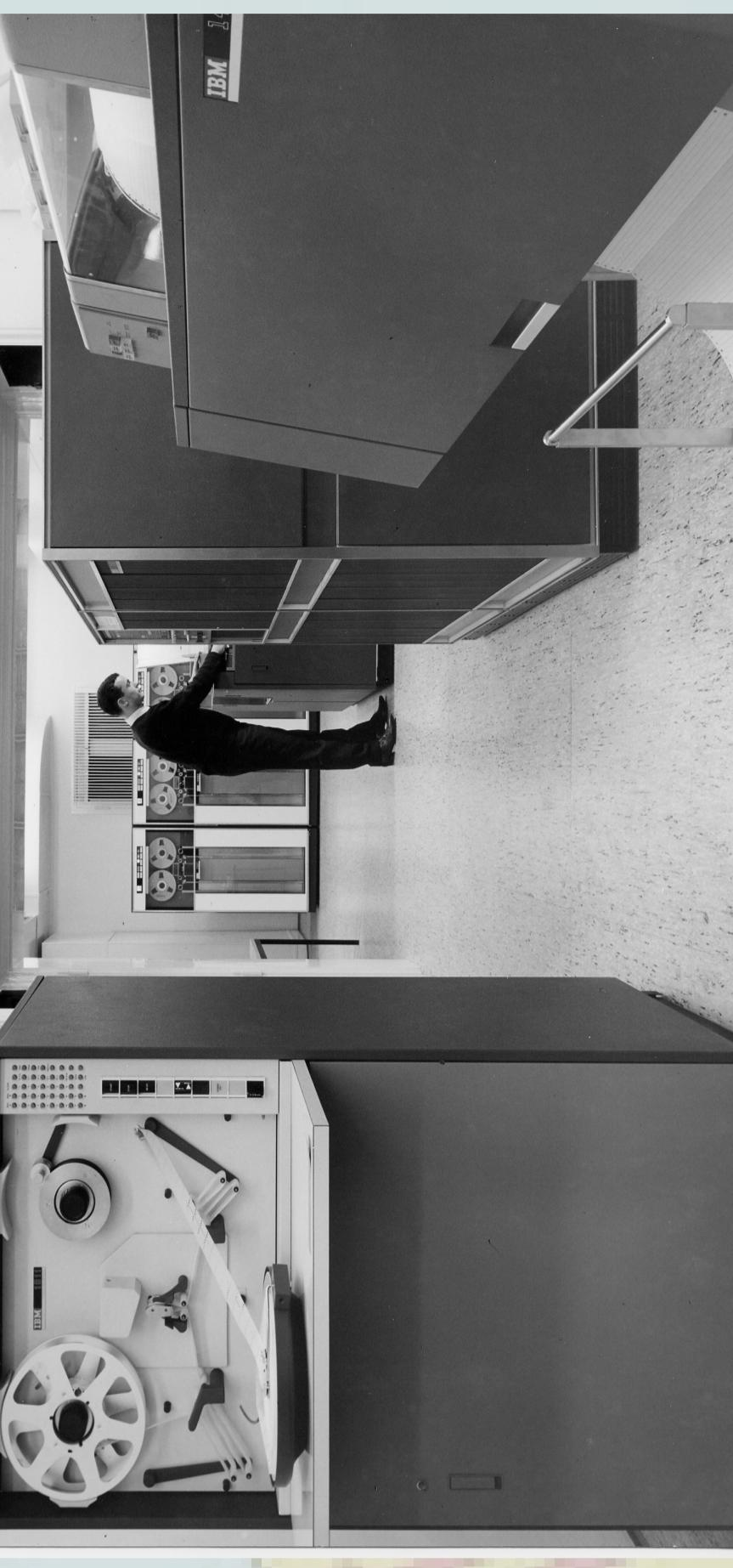
Die erste, 1965 am IHEP installierte Großrechenanlage war eine IBM 7040; man erkennt im Bild allerdings nur v.l. einen Lochstreifenleser, Magneteinheiten, einen Operator beim Einlesen von Lochkarten, eine IBM 1401 (auf der übrigens die erste elektronische Erfassung der Heidelberger Studenten durchgeführt wurde), sowie einen Endlos-Schnelldrucker. 1966 folgte die bereits erwähnte IBM 7090 aus CERN, sodann 1968 eine IBM 360/65.
